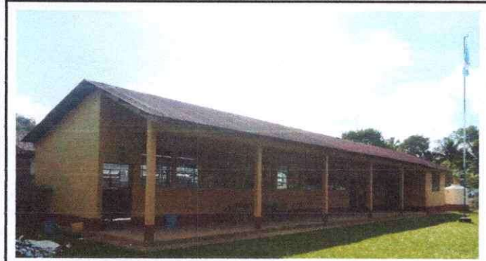
Foto 1: Sustitución de láminas de toda la escuela.
