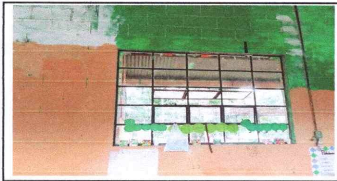
Foto 4: Repello de paredes,
