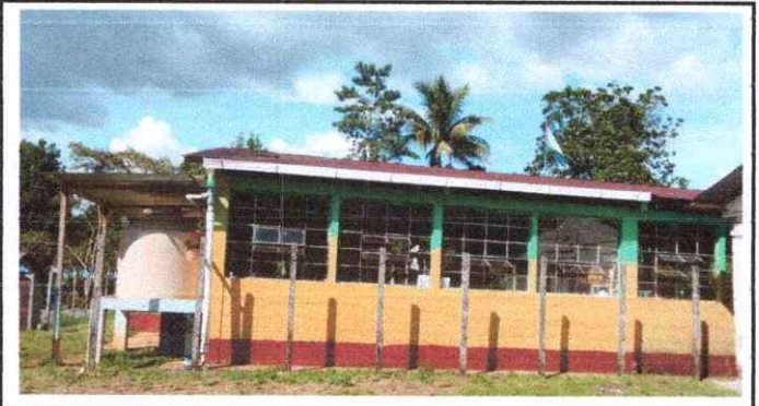
Foto 4: Pintura de interior y exterior.
