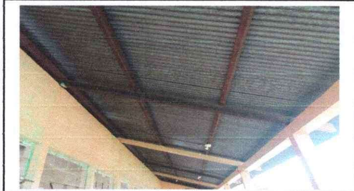
Foto 3: Pintura de costaneras, para evitar deterioro.
