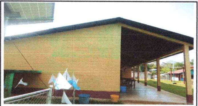
Foto 2: Cernido de paredes.
