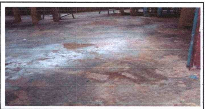
Foto 5: Cambio de piso de concreto, debido a que se encuentra en muy mal estado.
